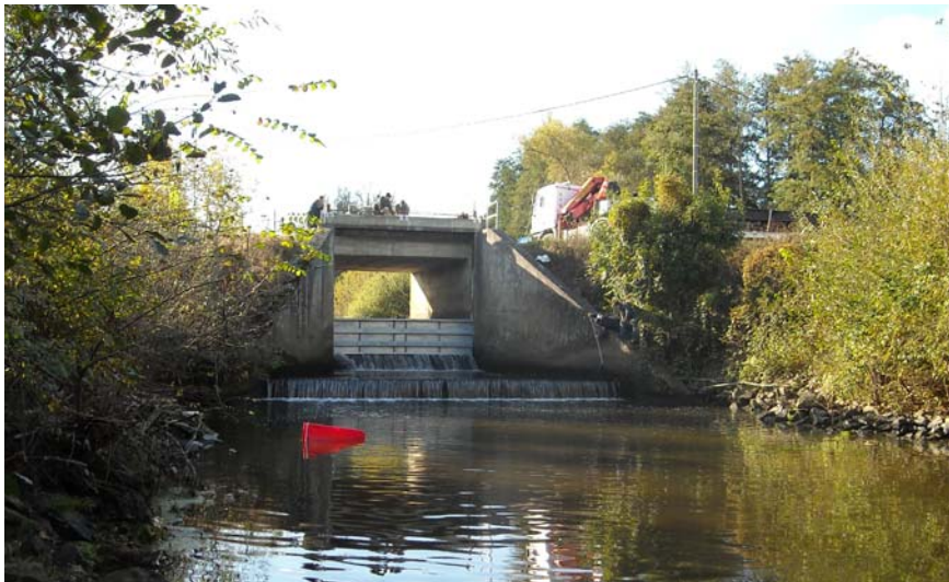
Figure 34 : La Vanne Lerchenberg (Amont Haguenau)
