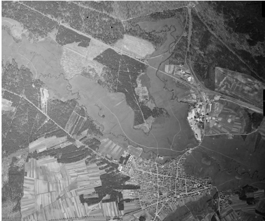
Figure 17 : Photo aérienne de la moyenne Moder sinueuse à la confluence avec la Zinsel du Nord à Schweighouse-sur-Moder avant les travaux de rectification (IGN, 1951)
