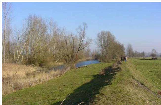
Figure 53 : Une digue de la Moder aval
