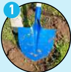
Creuser un trou de largeur et de longueur 40 cm et d'une profondeur de 50 cm à l'aide d'une pelle en évitant de compacter les parois.
